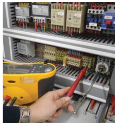
Ensaio elétrico (fonte: CATIM)
